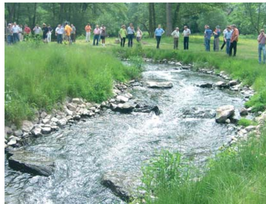
Umgehungsgerinne an einem Wehr
